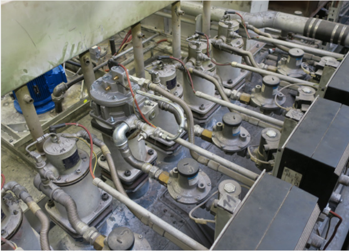
Bild 7: Austausch eines einzelnen Brenners, z. B. zum Probetrieb
